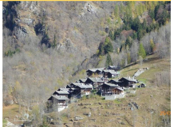
Alagna, fraz. Ronco (circa 1400 m s.l.m.): agglomerato di edifici iso-orientati, costruiti su un versante ripido
