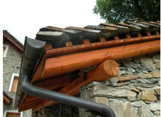
Tetto nuovo con manto con sormonto di sole due beole
