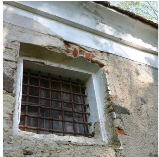
Muro esterno intonacato con malta di calce; cornicione e riquadro della finestra con finitura in marmorino (calce aerea, grassello, sabbia fine e polvere di marmo, nelle giuste proporzioni), tirato con ferro.
