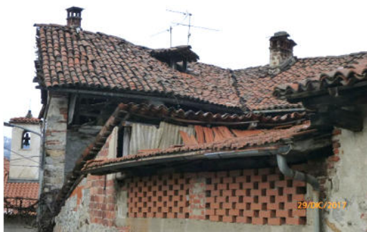
Manto in coppi e tamponamenti grigliati - Quarona
