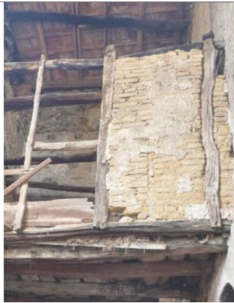
Antico tramezzo in mattoni crudi - Guardabosone
