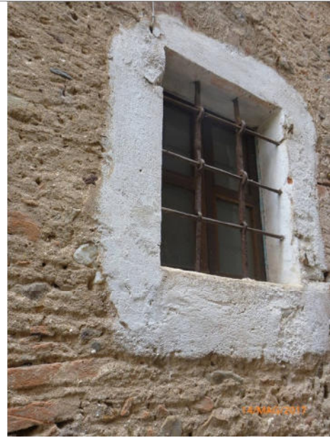
Muro in pietra e mattoni, con rinzafo di malta e cornice della finestra imbiancata con latte di calce
