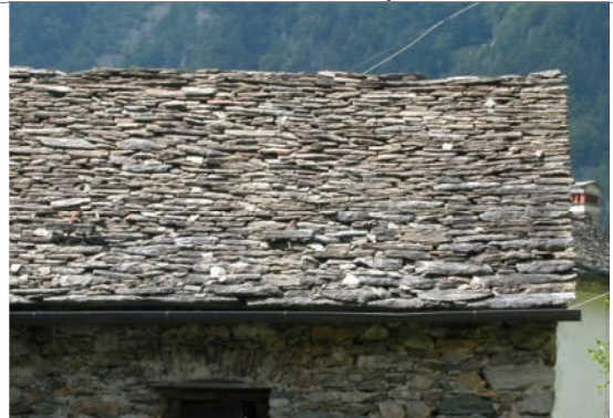
Val Mastallone, Fobello, fraz. Campelli: vecchio manto con piode locali di piccole dimensioni
