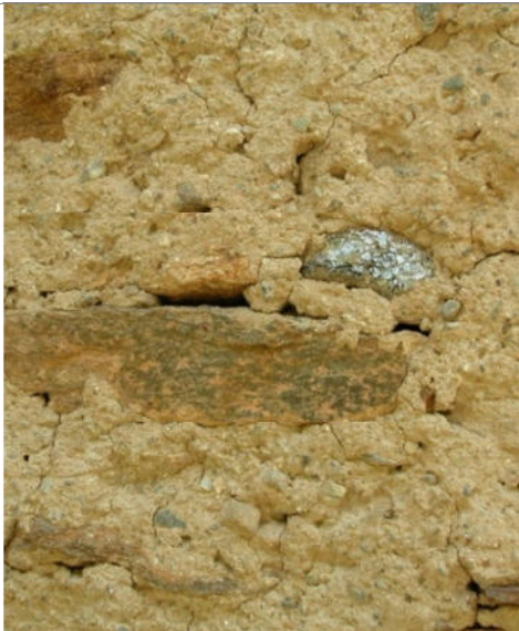
La sabbia inserita come inerte nell'impasto influenza la colorazione e la granulometria della malta
