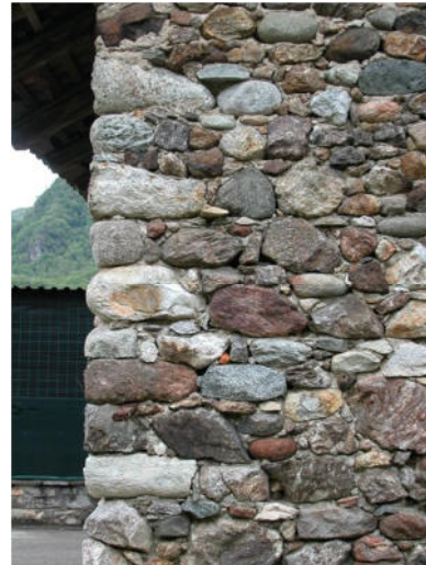
19- Doccio (Quarona): ciottoli di gneiss e anfiboliti prelevati nel greto del Sesia, lavorati a spacco per i cantonali
