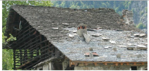
Rimasco: impiego separato in due differenti porzioni della falda, di vecchie piode e di beole nuove senza mescolanza dei due diversi materiali
