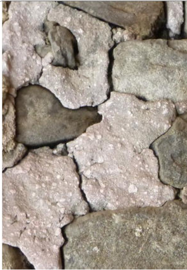
Malta di calce, spenta male, in cui sono visibili i bottaccioli (o calcinaroli), ossia grumi di calce che durante il processo di spegnimento non sono stati sufficientemente idratati.
