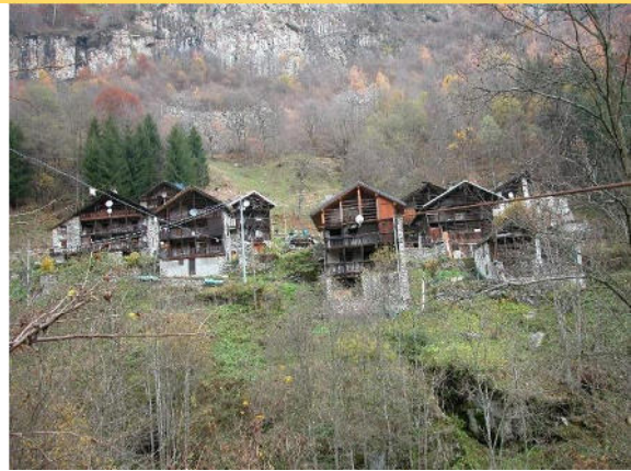
Rimasco, fraz. Ca' di Zelle, 985 m s.l.m.: iso-orientamento delle facciate provviste di loggiate in legno rivolto a Sud per l'essiccazione di foraggi e cereali
