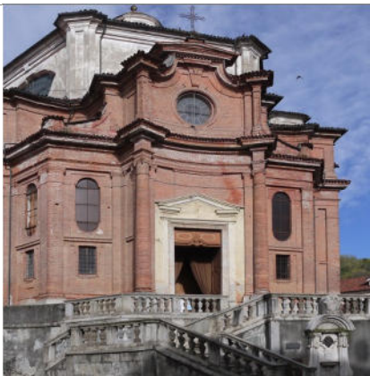
Mattone a vista in edifici monumentali - Grignasco
