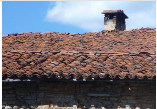
Manto in coppi - Vintebbio
