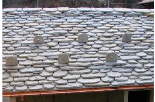
Fobello: manto con nuove piode, non locali, medio-grandi, posate con tecnica tradizionale
