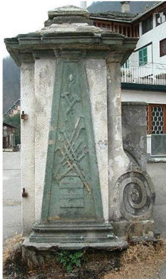
36- Scopello: pilastrino d'ingresso alla fonderia settecentesca in gneiss con lapide in roccia verde (serpentinite)
