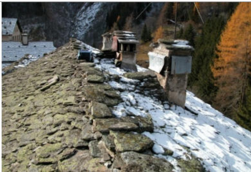
Vecchio tetto coperto in piode locali a Rima San Giuseppe: lastre con formato molto irregolare, dimensioni prevalentemente piccole, forte sovrapposizione, disposizione paragonabile a quella delle pietre di un muro a secco, senza allineamenti
