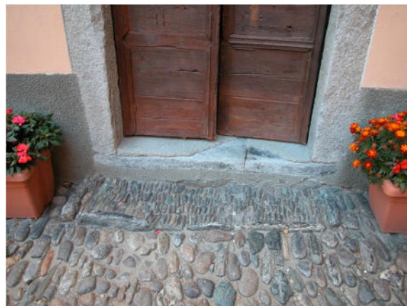
23- 'Castello' di Alagna: piedritti in gneiss e soglia in pietra verde (prasinite) come i ciottoli (serpentiniti) dell'antiporta (finto zerbino)
