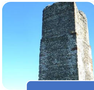
antica torre restaurata
