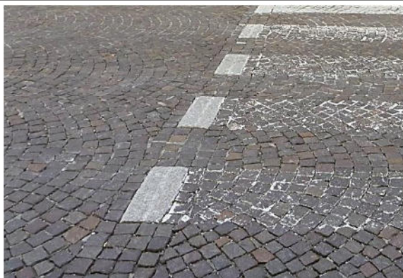
38- Serravalle: pavimentazione in cubetti di porfido
