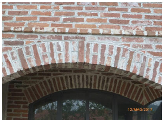
Arco in laterizi - Guardabosone
