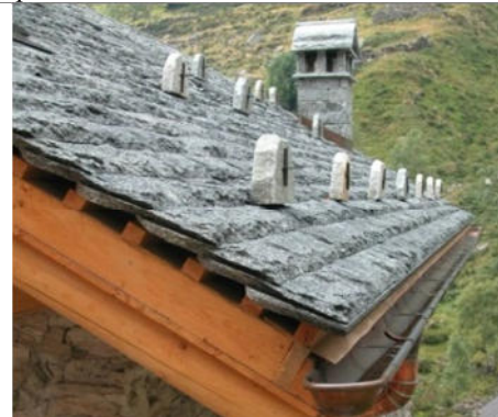
Nuovo tetto con elementi lapidei di formato regolare, spessore e dimensioni costanti, posati a file parallele, analogamente a un rivestimento della falda
