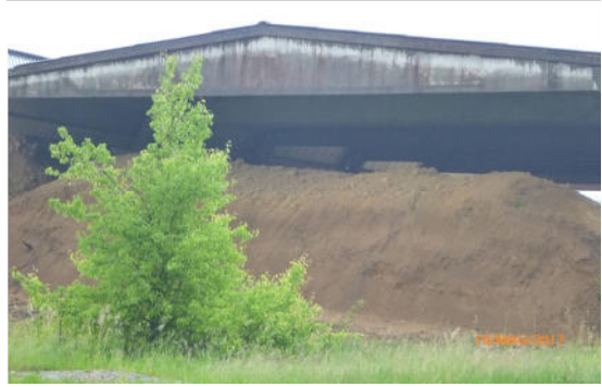
Capannone con materiale cavato- Lozzolo
