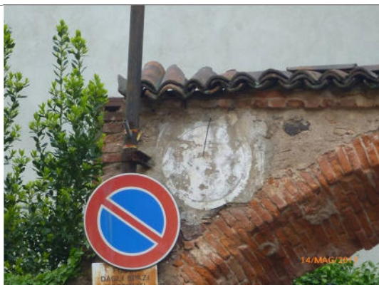
Arco in laterizi - Maggiora
