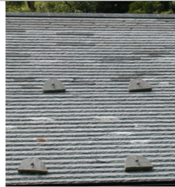
Nuovo tetto con elementi lapidei di formato regolare, spessore e dimensioni costanti, posati a file parallele
