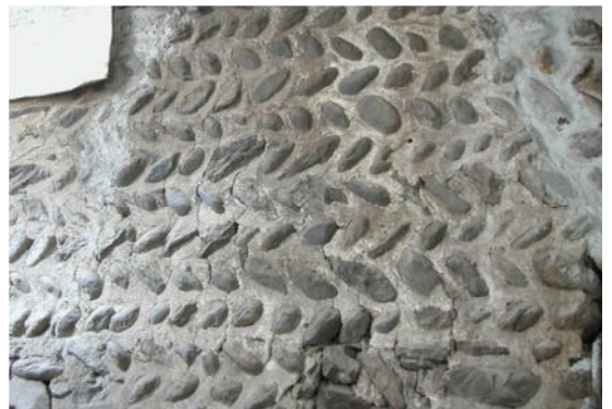
17- Balmuccia: ciottoli equidimensionali del Sesia con disposizione a spina di pesce
