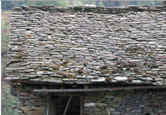
Val Sermenza, Boccioleto, fraz. Piaggiogna: vecchio manto con piode locali di piccole dimensioni
