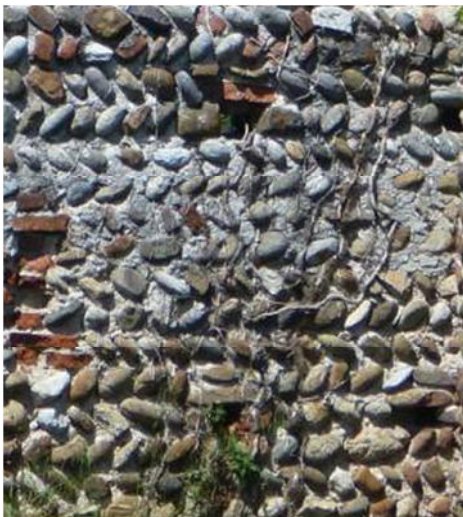
16- Prato Sesia, loc. Sopramonte: ciottoli equidimensionali del Sesia disposti a spina di pesce
