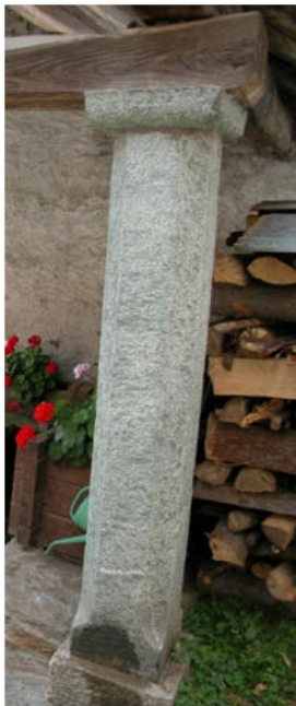
26- Piedimeggiana (Piode), complesso della fontana e del lavatoio: pilastro in gneiss massiccio
