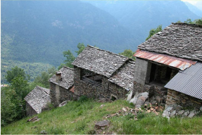
Mussoit, 1100 m s.l.m. alpeggio di Scopello. Situazione di ripido pendio: allineamento dei fabbricati rurali perpendicolare alle linee di livello, onde godere della massima esposizione al sole su tre prospetti
