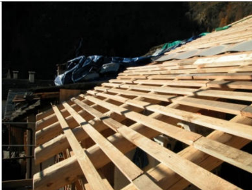
Nuovo tetto: la listellatura è a distanza fissa, dipende dalla pendenza della falda e determina la pendenza e la sovrapposizione delle lastre di beola
