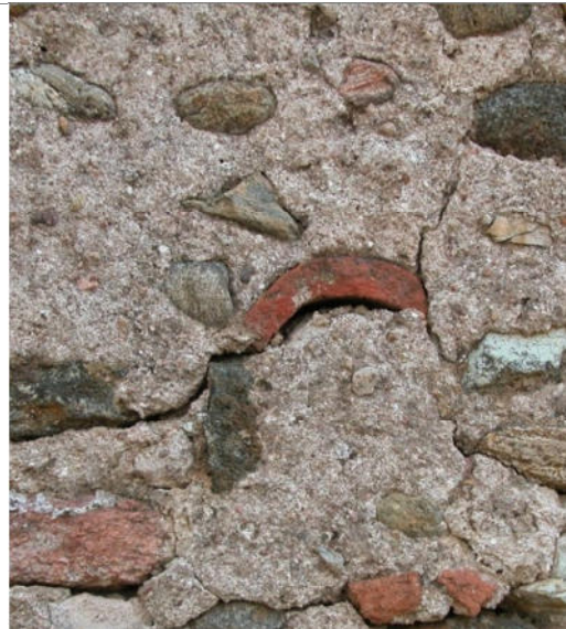
Malta idraulica ottenuta aggiungendo coccopesto a una calce aerea
