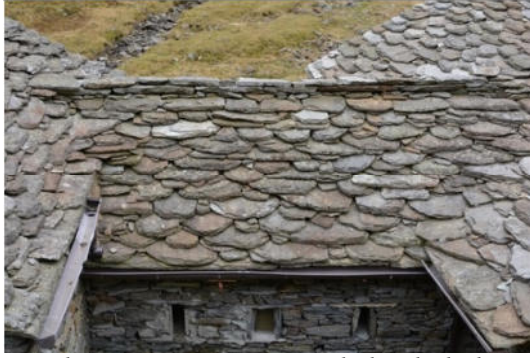
Alagna, alpe Bors: manto con piode locali di dimensioni medio grandi, lavorate a mano
