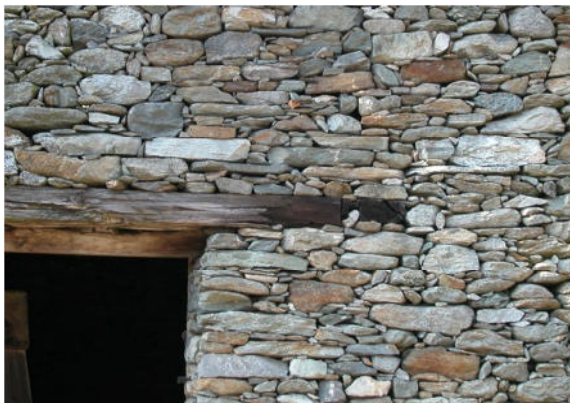
8- Scopa: muro in elementi prevalentemente tabulari di gneiss
