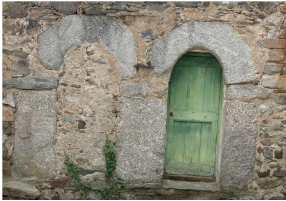
24- Brugaro (Cravagliana): archi monolitici impostati su rudimentali capitelli posati su massicci piedritti, tutto realizzato in gabbro
