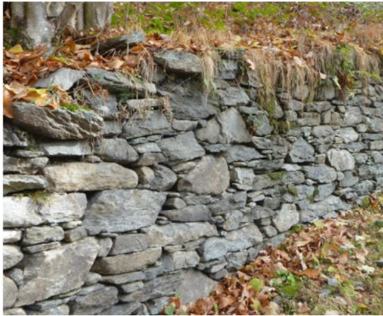
12- Piana Fontana (Mollia): muro a secco in blocchi di gneiss massiccio grezzo
