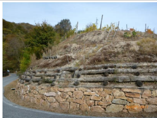
39- Strada della Traversagna (Grignasco-Boca): argine stradale in blocchi squadrati di porfido
