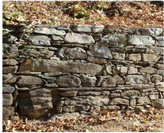
13- Rossa: muro a secco in elementi di gneiss massiccio lavorato
