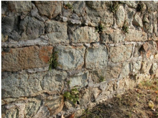
20- Torre di Cavallirio: elementi basali squadrati in piroclastiti (tufi)
