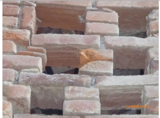
Vecchio muro grigliato degradato - Boca
