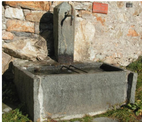
29- Sabbia, fraz. Erbareti: fontana a lastre assemblate in diorite
