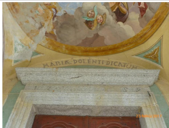
33- Cervarolo (Varallo): portale con piedritti e architrave in granito
