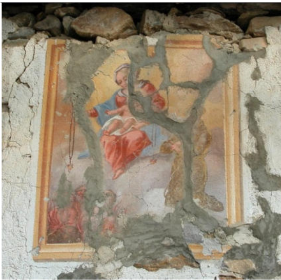
Deplerevoli e grossolane stuccature in cemento, che oltre a essere esteticamente inaccettabili risultano dannose per la conservazione delle pitture ad affresco
