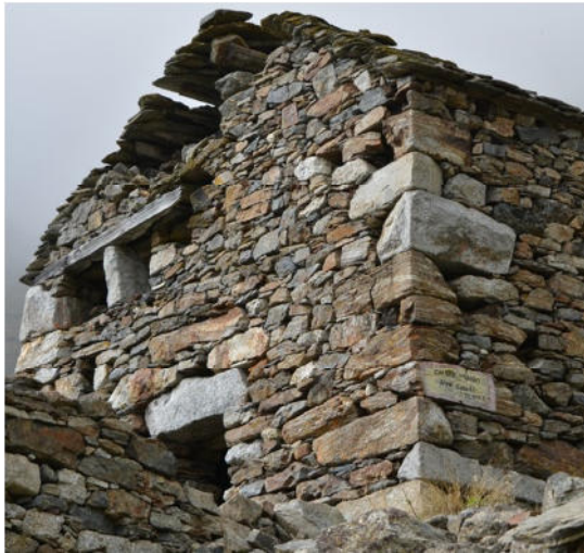
18- Alpe Cuvàa (Rossa): grossi elementi cantonali lavorati in gneiss massiccio
